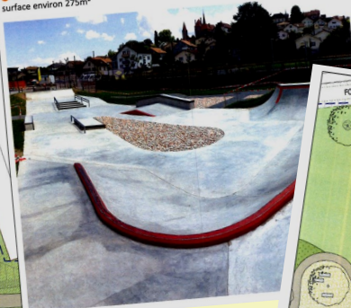
● Skate park en béton, surface environ 275m 2
